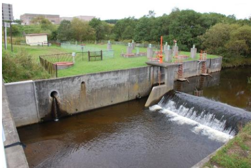
魚道設置前の三郎川取水堰 (2008年9月)
